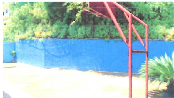
REPARACIÓN DE MUROS DE CONTENCIÓN
